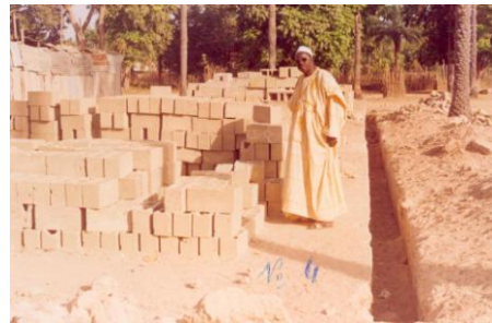
Les briques fabriquées pour reconstruire le bâtiment « B. Lacroix » Mr Bacary Diedhiou, directeur de l'école
