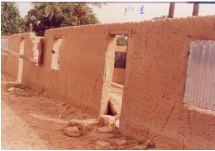
Bâtiment « B.Lacroix » en banco dont le toit a été emporté par l'orage à la saison des pluies
